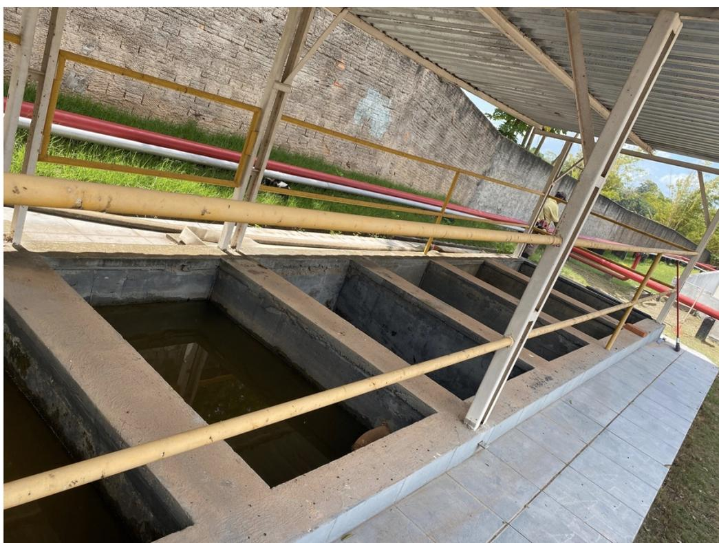
Aqui trata-se de um sistema de decantação para tratamento da água que será lançada no rio, removendo todos os resíduos de combustíveis, evitando contaminação do solo e da bacia fluvial.
