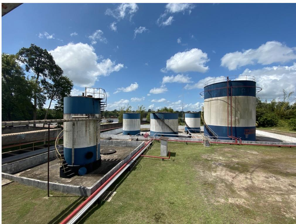
Dos 4 tanques de combustíveis, vistos na foto acima (mais ao fundo), dois estão em operação. O tanque em primeiro plano é um reservatório de água.
