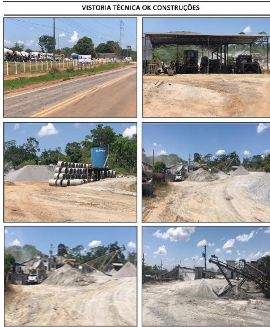
Figura 2 – Vistoria Técnica a Empresa OK Construtora.
