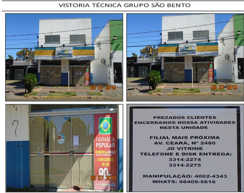
Figura 29- Imagens da vistoria Av. Bom Pastor, nº 894- Centro (FECHADA)
