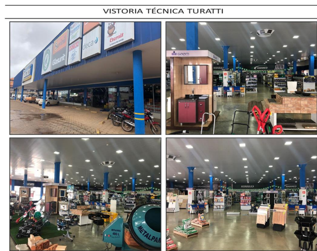
Figura 2- Imagens da vistoria
