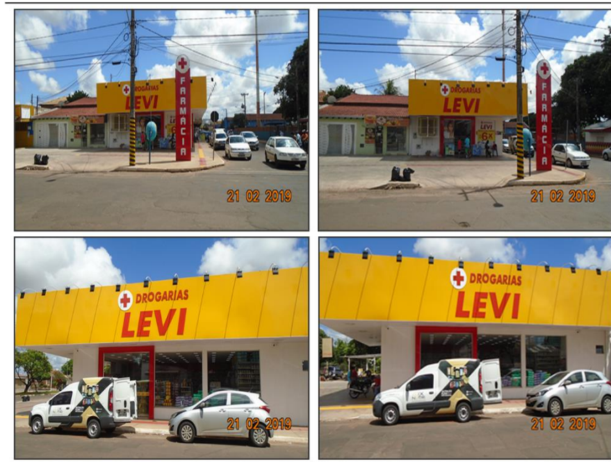
Figura 7- Imagens da vistoria Rua da Península, nº736, Bairro Coophavilla II.
