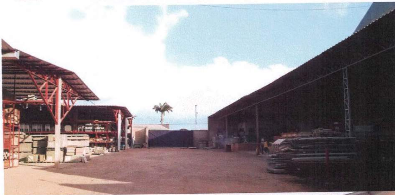
Imagem 02 – Três unidades edificadas sobre o lote
