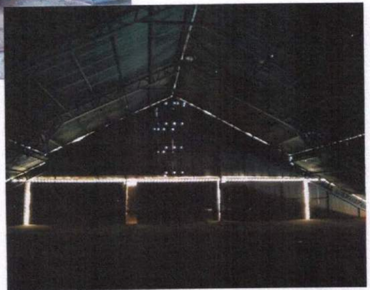
Imagem 07 – Unidade 03 (Cobertura parcial)
