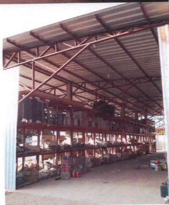
Imagem 03 – Estrutura, cobertura e piso
