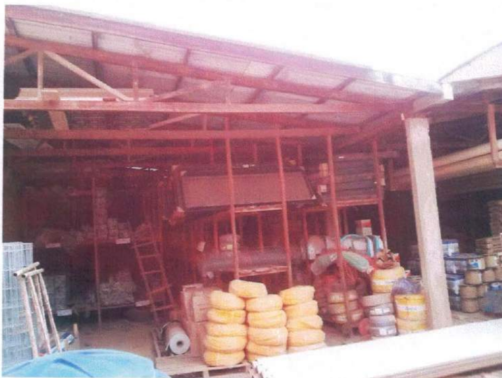
Imagem 06 –Depósito externo (Estrutura da cobertura em madeira com fechamento em telhas de fibrocimento)
