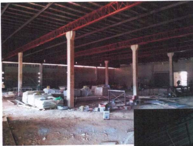
Imagem 06 – Unidade 03 (Parte em reforma)
