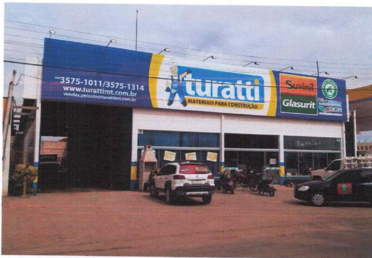
Imagem 03 – Frente do imóvel em avaliação
