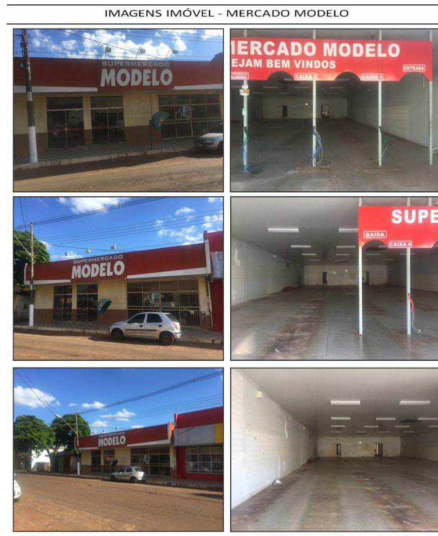
Figura 1: Imóvel onde funcionava o Supermercado
