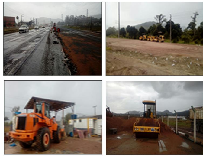
Figura 1 – imagem da vistoria realizada.
