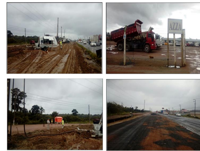
Figura 4 – imagem da vistoria realizada.
