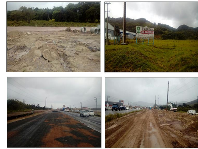
Figura 3 – imagem da vistoria realizada.
