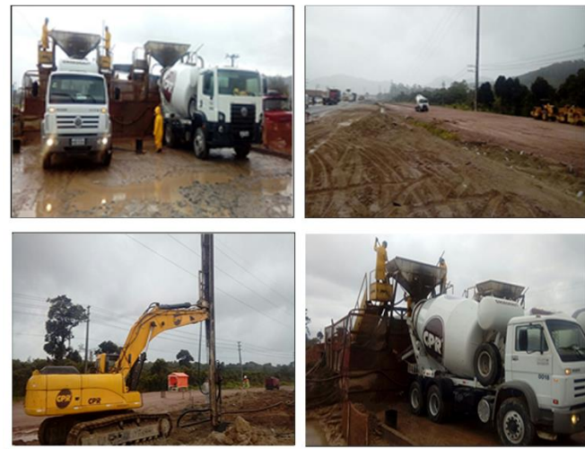
Figura 2 – imagem da vistoria realizada.
