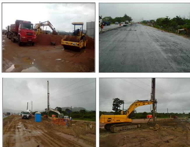
Figura 6 – imagem da vistoria realizada.
