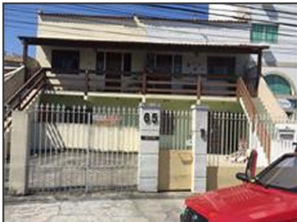
Figura 1 – Imagem Retiradas na Vistoria – Fachada Atual
