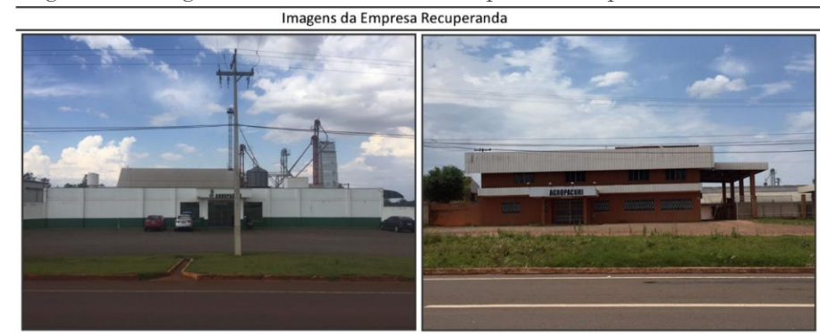
Figura 1 - Imagem da unidade sede da empresa Recuperanda
