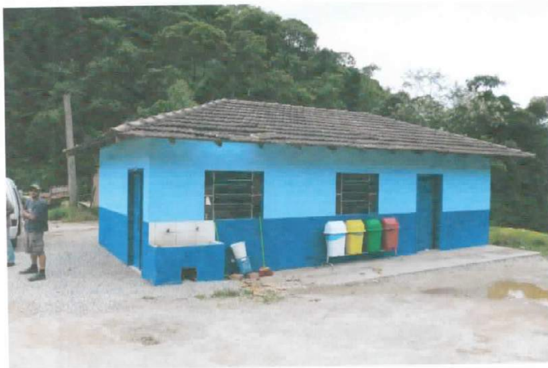
FOTO 11: Vista geral do pavilhão de alvenaria com telhado de 4 águas, onde está instalado o Refeitório da pedreira.
