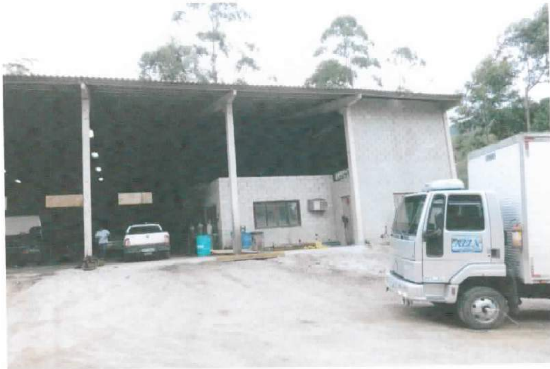
FOTO 08: Vista do galpão pré-fabricado de concreto, onde é feita a manutenção geral de veículos da pedreira. Nesta porção é que ficam os escritórios, almoxarifados e gerência das oficinas.
