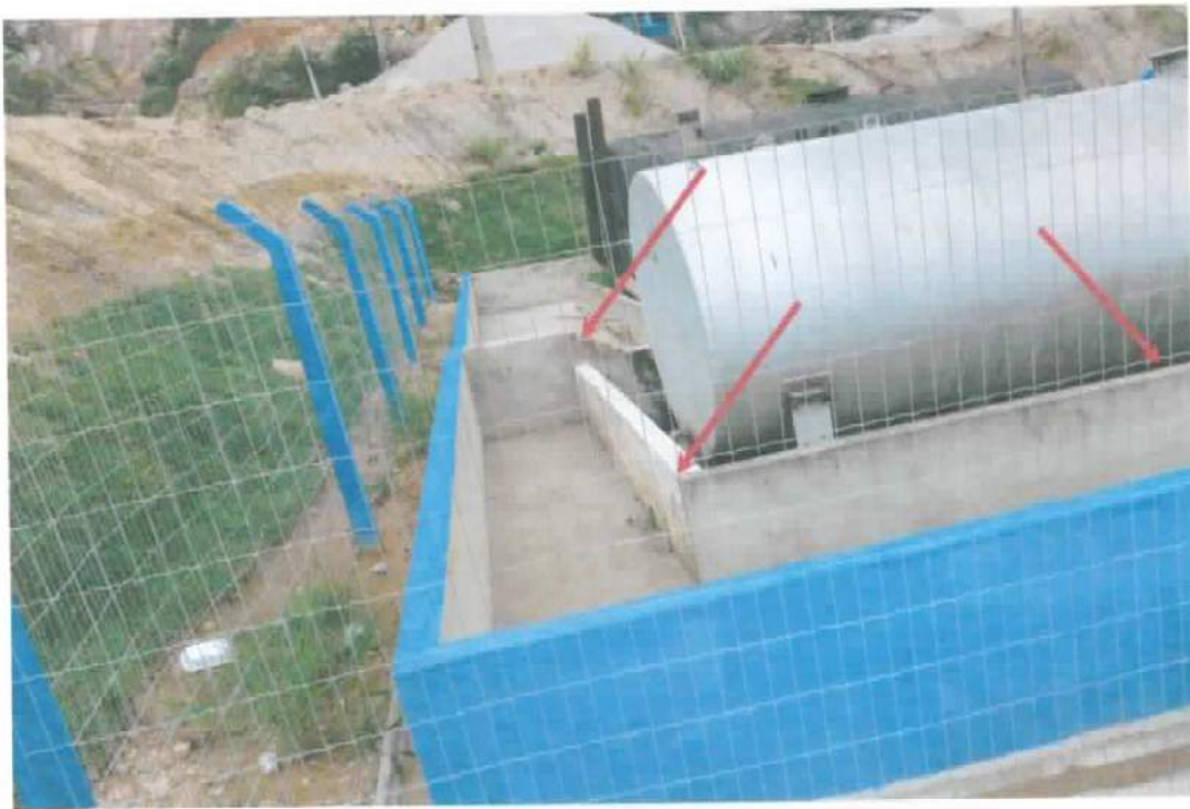
FOTO 14: A seta aponta o detalhe do piso de concreto na parte interior da tancagem, bem como o septo de separação do tanque de combustível dos demais ali contidos.
