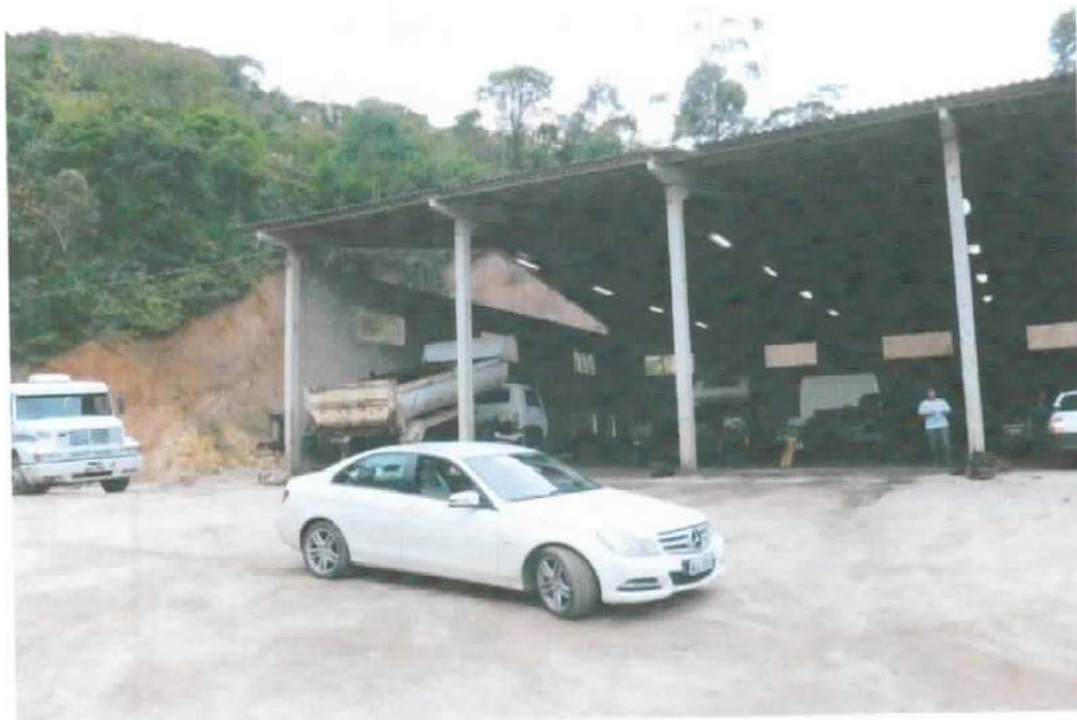
FOTO 08 A: Vista complementar do galpão pré-fabricado mostrando sua parte aberta.
