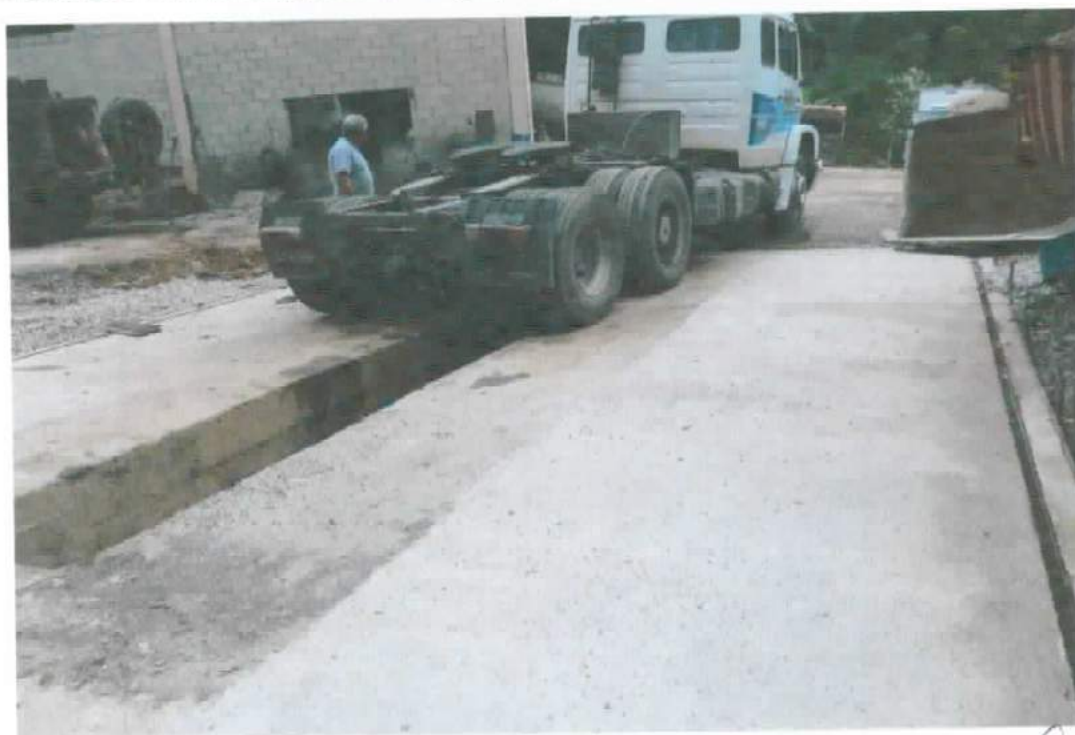
FOTO 09: Vista geral da rampa de lubrificação de veículos e equipamentos.
