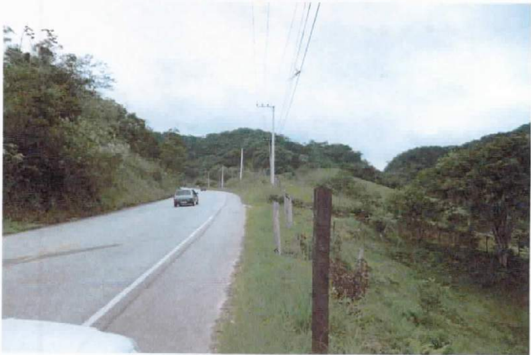
FOTO 01: Vista geral da SC 486, onde se pode perceber que um dos terrenos se situa a direita da foto e o outro a direita da mesma rodovia.
