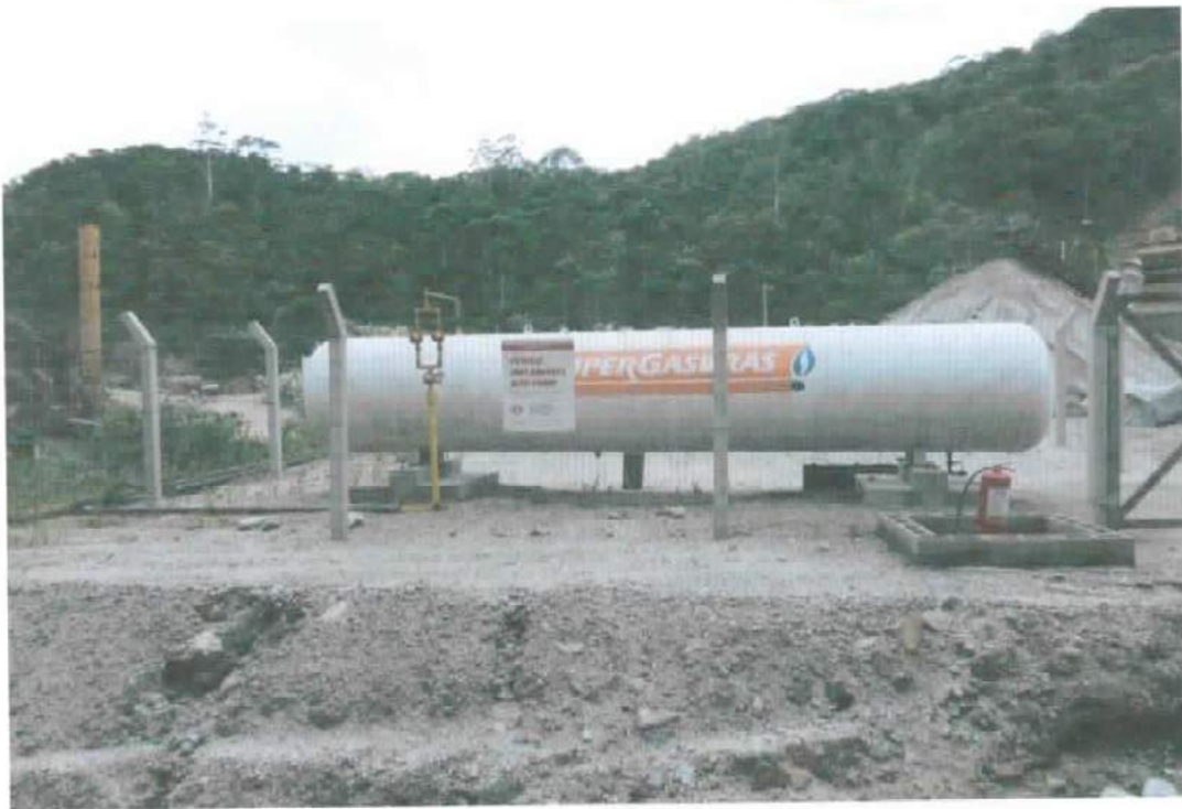
FOTO 16: Vista geral da central de gás da pedreira, cercada com alambrado metálico e assentada sobre pavimentação de brita.
