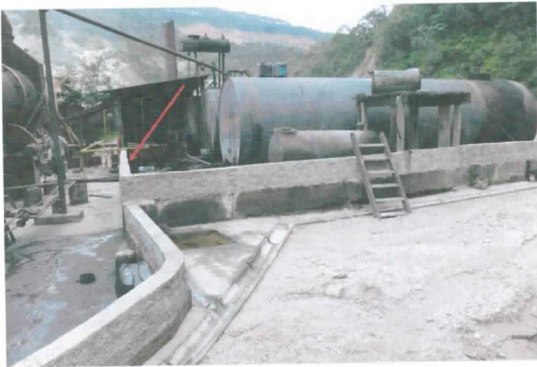
FOTO 13: Foto sequente mostrando a extensão geral deste dique de contenção de líquidos.
