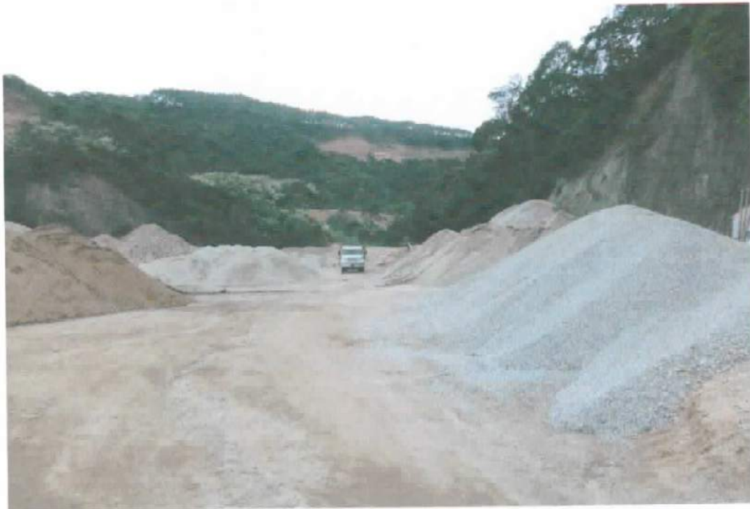
FOTO 17: Vista geral da estrada de serviço e operações da pedreira pavimentada com brita e areia em toda extensão do terreno, sendo parte de uma área total de 18.000,00 m 2 pavimentada em toda a pedreira.
