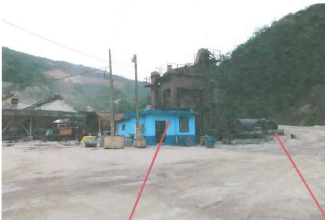
FOTO 12: Vista geral da cabine de comando da formulação de CBUQ e o dique de contenção de líquidos em concreto, do lado direito.
