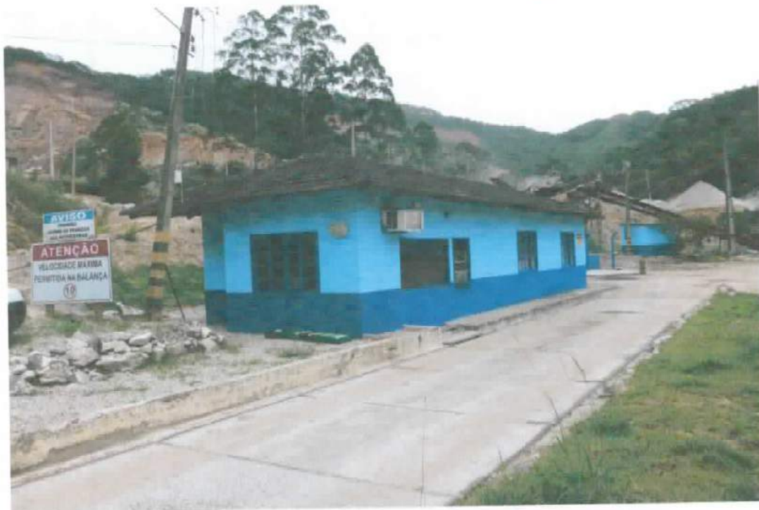
FOTO 10: Vista geral da casa do controle da balança de viaturas e equipamentos rodantes. OBS.: Ainda que as placas da balança sejam de concreto armado elas não foram avaliadas, pois o avaliador entende serem elas peças do equipamento balança veicular e, bem por isto, se excluem do objeto Avaliação de Benfeitorias.
