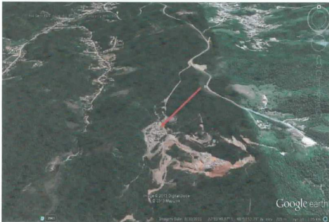
FOTO 01: Vista geral dos terrenos onde se situa a pedreira da AZZA, onde a direita se vê a SC 411 serpentear em seus entornos. Imagem obtida no programa Google Earth.
