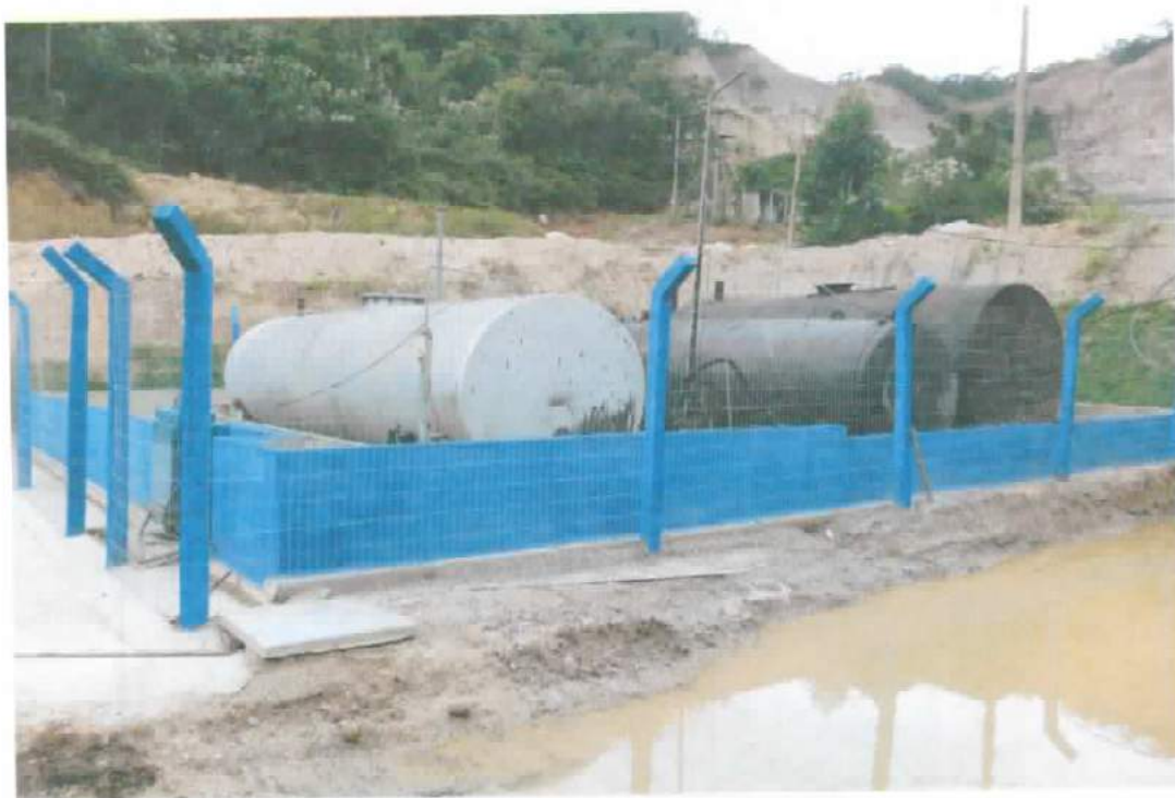
FOTO 14: Vista geral de outra tancagem, onde além do dique de contenção há uma cerca de arame guarnecendo os tanques.
