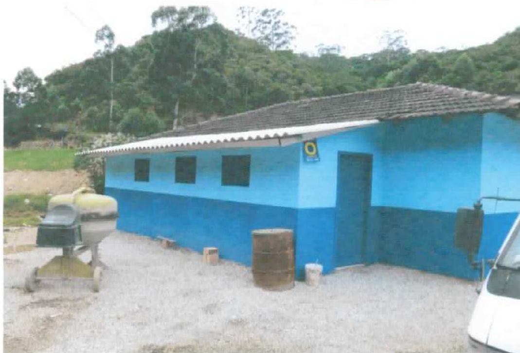
FOTO 11 A: Vista geral da parte dos fundos do Refeitório.
