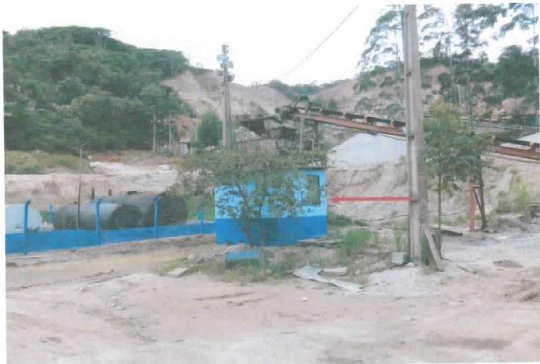
FOTO 15: Vista geral sequente, onde se vê a casa de apoio ao lado da tancagem vista nas fotos anteriores.
