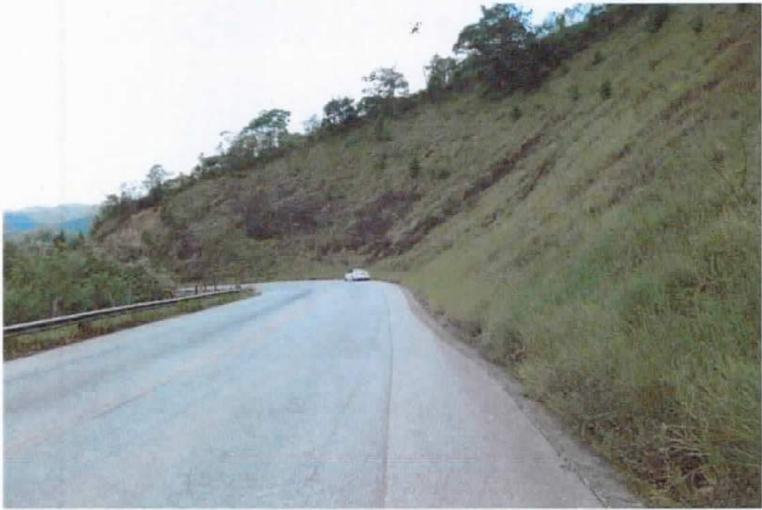
FOTO 03: Vista geral do terreno da esquerda da SC 486, onde há um platô que é acessado pela entrada mostrada na foto anterior.
