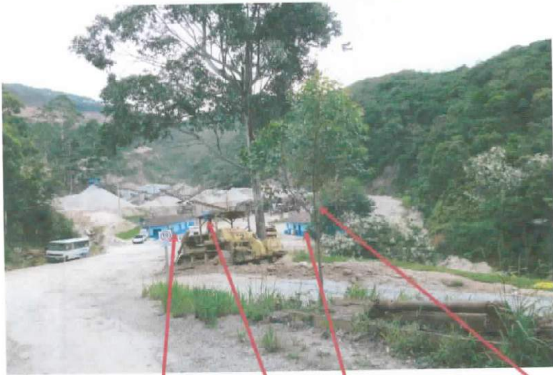
FOTO 07: Vista geral da pedreira em plena operação, onde se pode perceber; a casa do controle e operação da balança, guarita de apoio, cabine de controle e formulação de CBUQ e a casa térrea mais na frente da foto e a direita é o Refeitório. Esta foto foi tomada da pista da plataforma de carregamento de betume.
